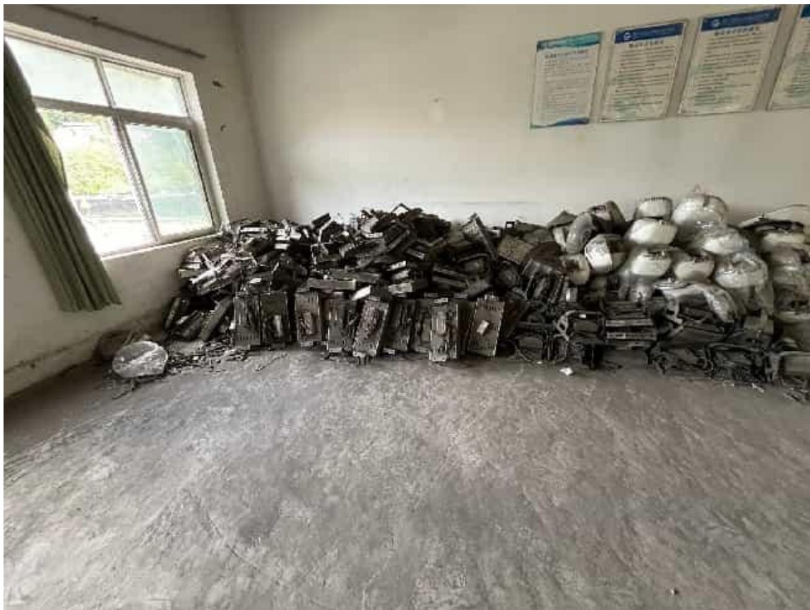
隧道机电设备14-照明灯具 (4)
