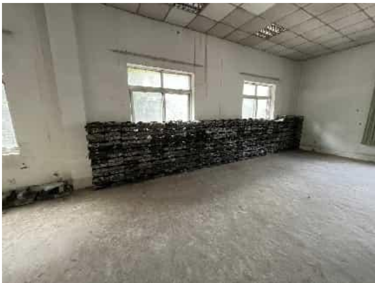
隧道机电设备11 -照明灯具 (2)
