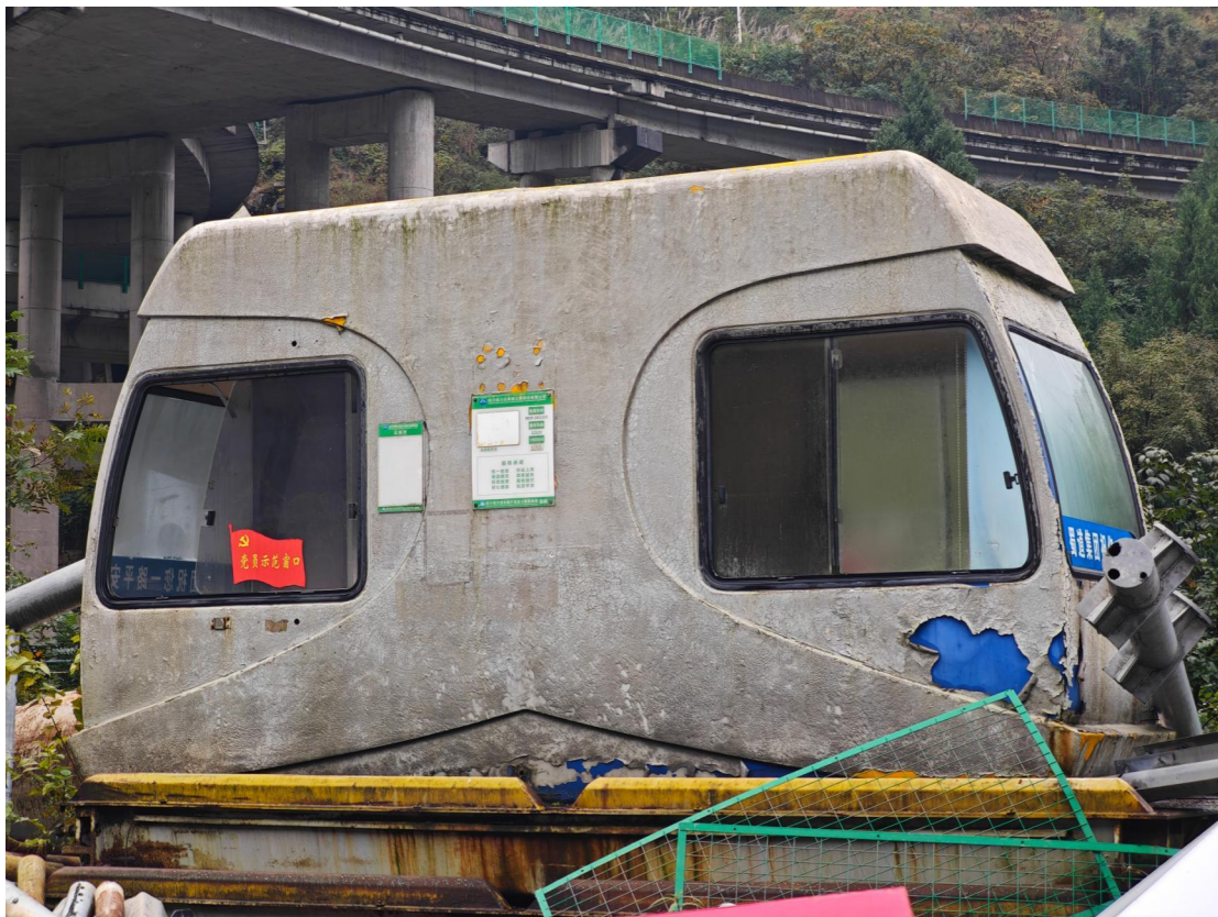
收费设施-1-7朝天库房-玻璃 钢单向、双向收费亭 (3)
